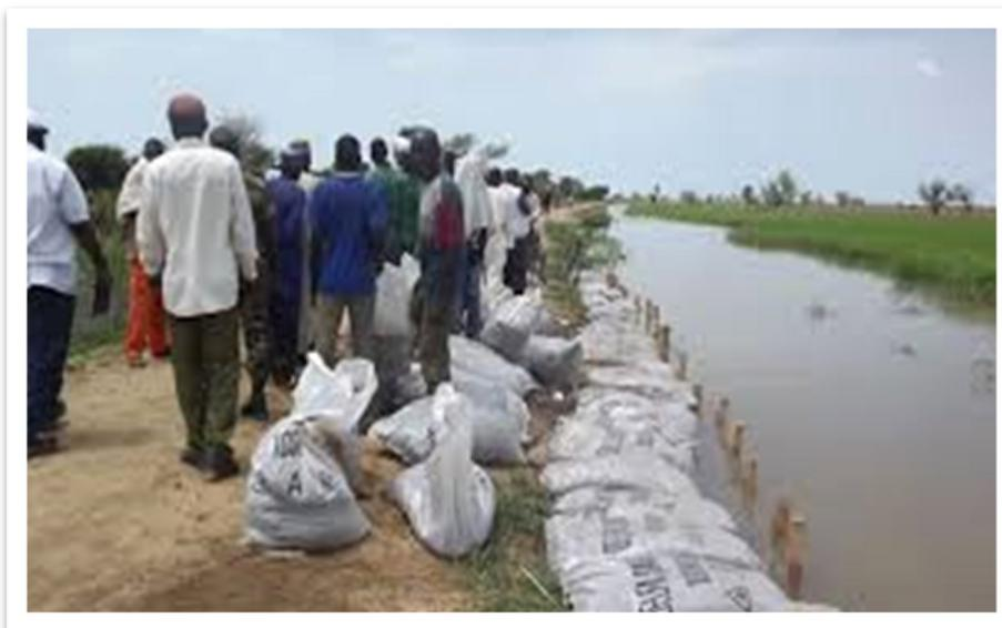
**Photo 2.** Protection de berge suite à la rupture de la Digue Maga dans l’Extrême-Nord Cameroun
