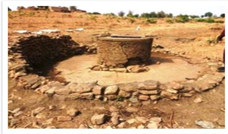
**Photo.4.** puit endommagé par les inondations
