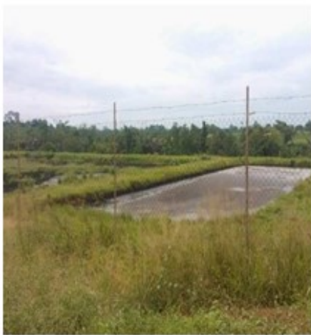
Déchets liquides exposés à l'air libre
