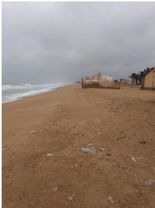
Impact de l'érosion côtière sur la plage de Grand Popo/ IMG Hippolyte Agossou
