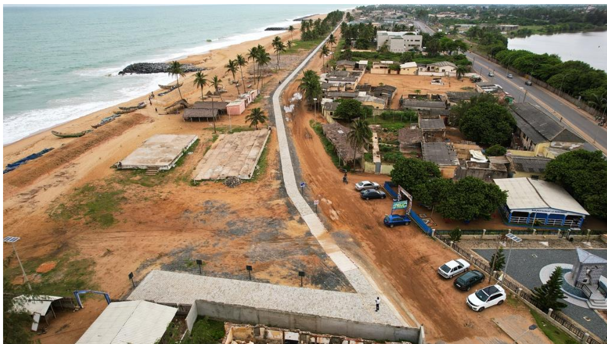
Vue d'une partie de la côte togolaise
