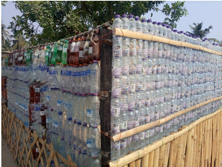
Clôture réalisée avec des bouteilles plastiques dans la localité d'Azizanya à 109 km à l'Est de la capitale ghanéenne. Crédit : Fulbert ADJIMEHOSSOU
