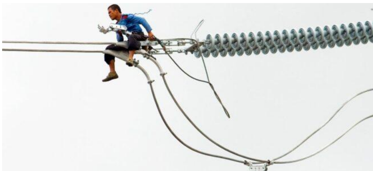
© ILO/Bobot Go Aux Philippines, un ouvrier installe un nouveau câble électrique au sommet d'un pylône.
