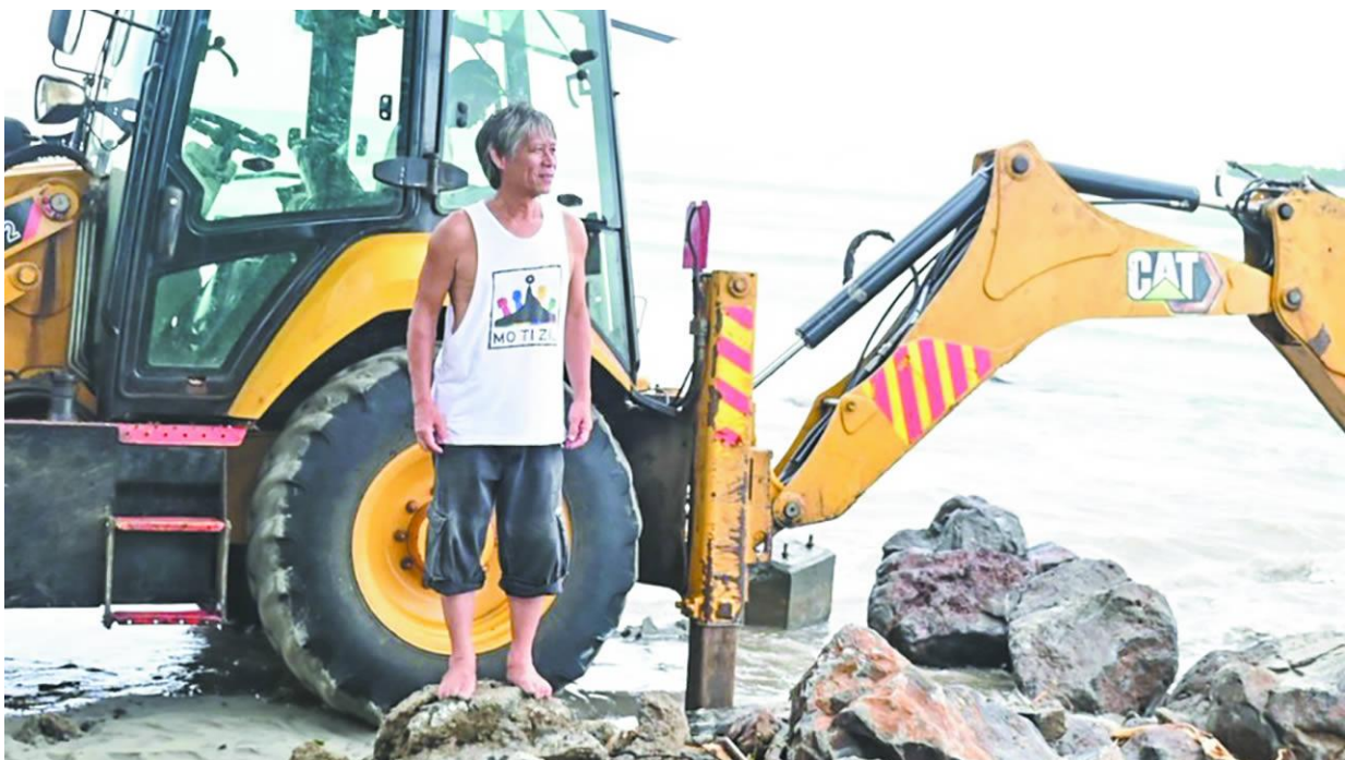
Percy Yip Tong a entrepris des travaux pour rouvrir l’embouchure de la rivière.
