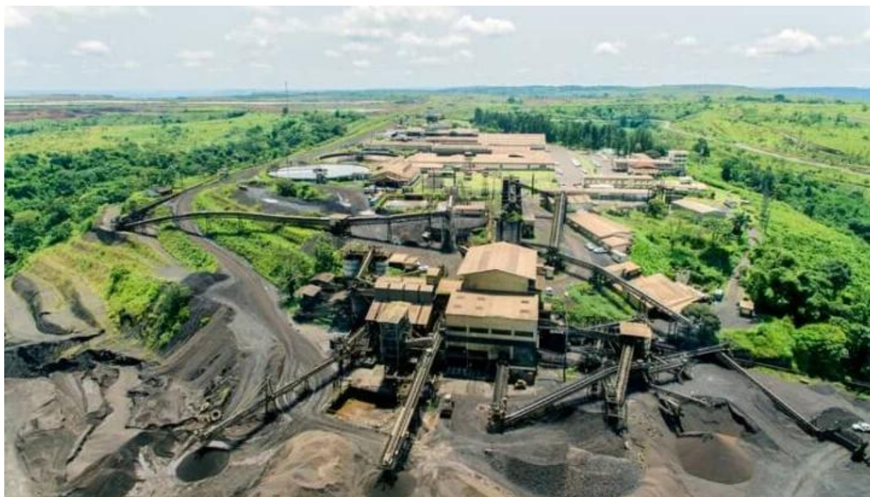
Si de traitement du manganèse, Moanda
